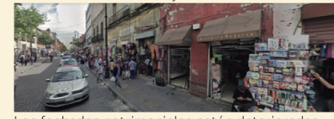
Las fachadas patrimoniales están deterioradas.
